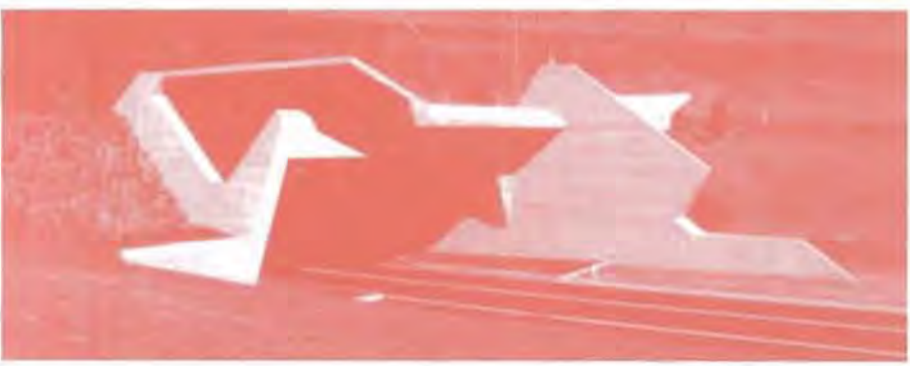
Rino Tami. Portale Sud della galleria autostradale del San Gottardo, 1969 - Archivio del Moderno, Accademia di Architettura di Mendrisio
