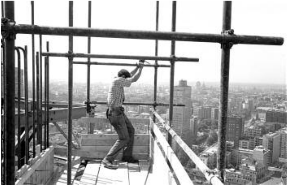
Arno Hammacher, Grattacielo Pirelli. Operaio allestisce i ponteggi, Milano, 1958
