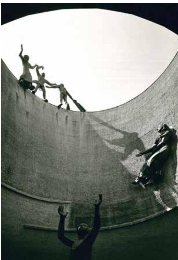
Archivi Storici, Area servizi Bibliotecari di Ateneo Politecnico di Milano – Archivio Piero Bottoni Piero Bottoni, Monumento ossario dei partigiani alla Certosa, Bologna 1954-1959, vista dell'interno
